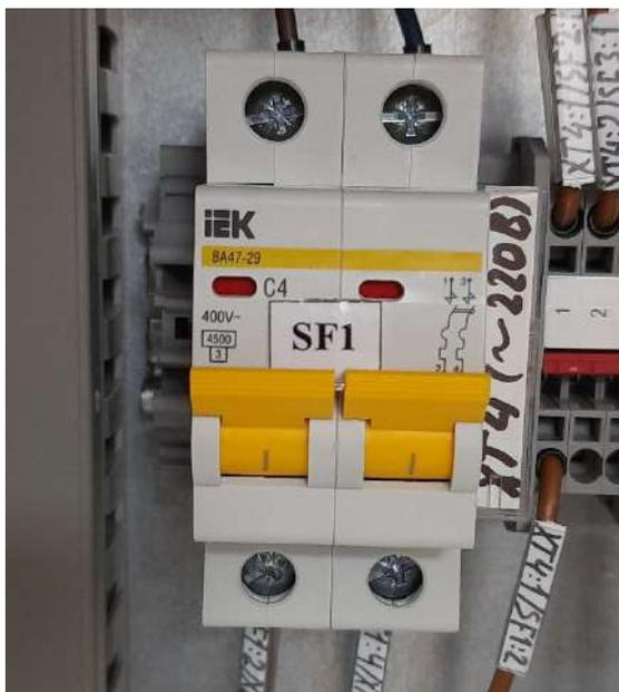
Рисунок 12 – Выключатель питания шкафа управления (SF1).
